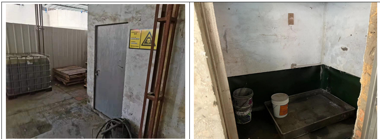
图 3-5 项目危废间图片
